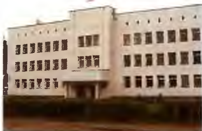
Здание администрации муниципального объединения «Устьянский район», в котором проходила конференция
