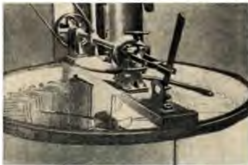
Рис. 98. Большая 50-рамочная радиальная медогонка, оборудованная кассетами Роуздейла, которые сводят к минимуму поломку сотов в процессе откачки
