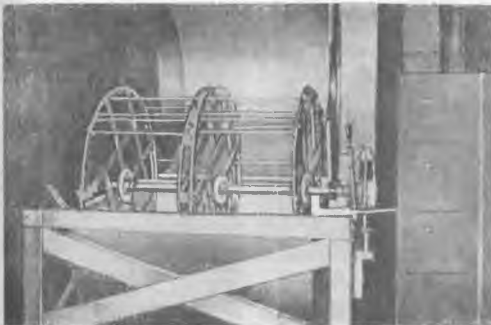
Рис. 10. Медогонка Ходжсона имела такой вид лет 25 назад. После усовершенствования она вмещала 8 кассет с 12 распечатанными сотами в каждой. Соты вращаются в вертикальной плоскости.
