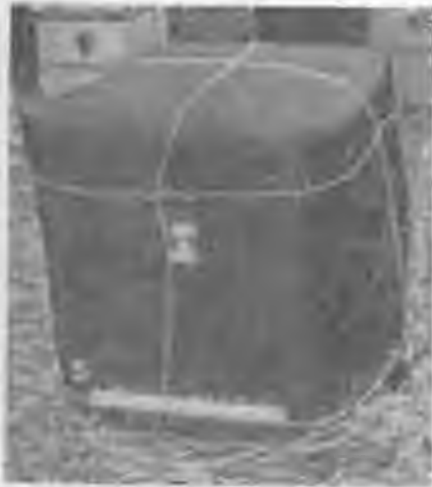
Рис. 5. Оба листа толя туго обвязывают двумя кусками бечевы.
